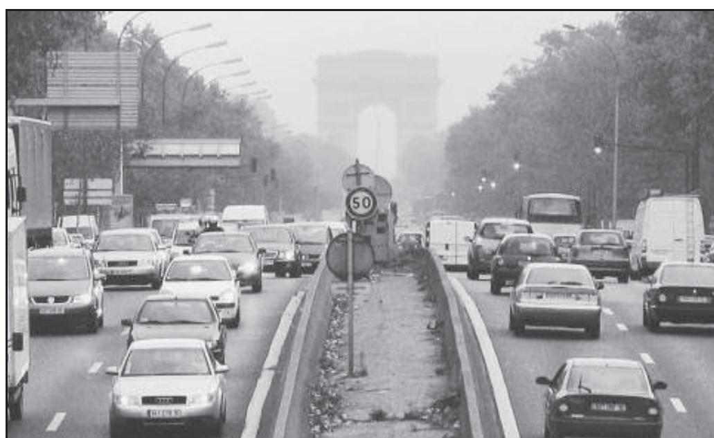
NEUILLY, OCTOBRE 2005. Un comité de pilotage permettant d'étudier les modalités du projet de couverture de la N 13 et sa faisabilité financière devrait se réunir d'ici la fin de l'année. (L.P.)
